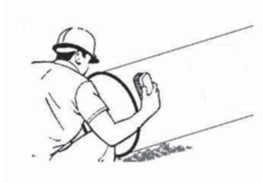
Рисунок Б.1 – Очистка поверхности трубы
